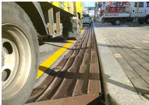
<그림 2-5> 불법으로 설치한 차량 진입판 사례
