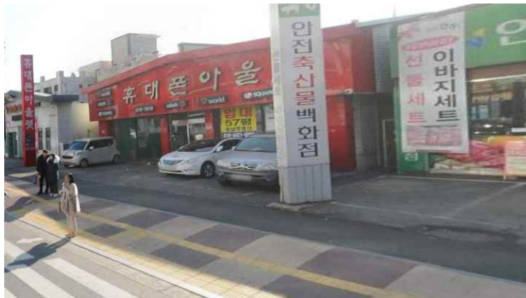
<그림 2-4> 차량의 출입구가 횡단보도를 지나는 사례
