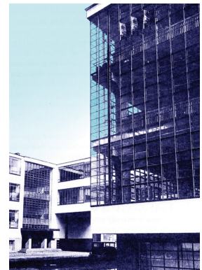
<그림 3> Bauhaus의 유리 커튼월, Gropius의 ‘Bauhaus, Dessau, 1926’. (S. Giedion, Space, Time and Architecture , p. 451)
