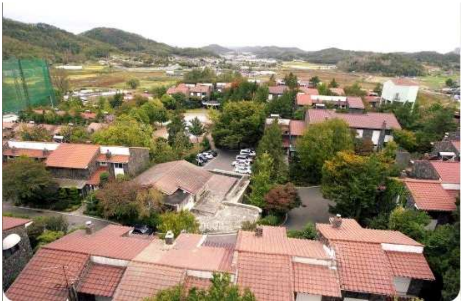
그림1. 구로 향동에 위치한 그린빌라 전경 39)
