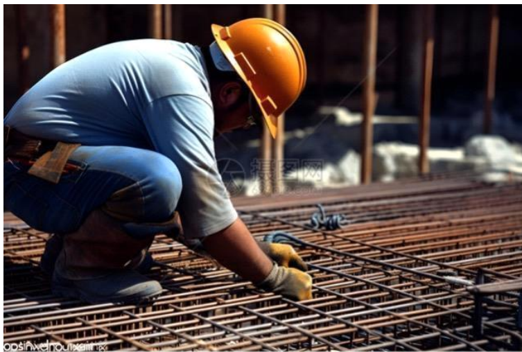
참고 도판 12) 건설 현장 철근 바인딩 현장 출처:
