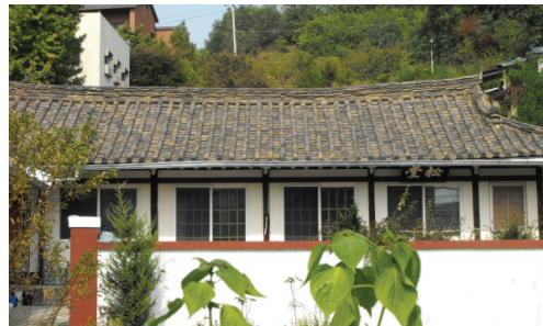
<사진 4-8> 진성이씨 송재종가 전경
